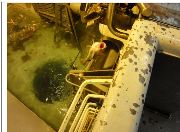
Bilde 3 Dragerbrønn og basseng
