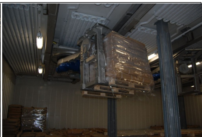
Bilde 27 Kraning til plass i lasterom
